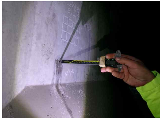
탄산화깊이 측정 현황
